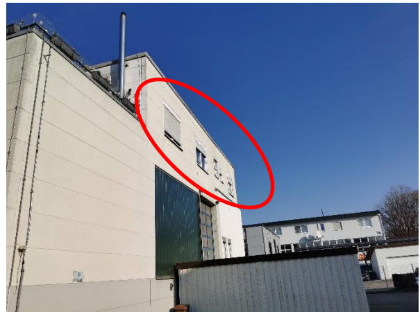
Abb. 17: Rollladenkästen auf Ostseite der Sulzbacher Straße 176
