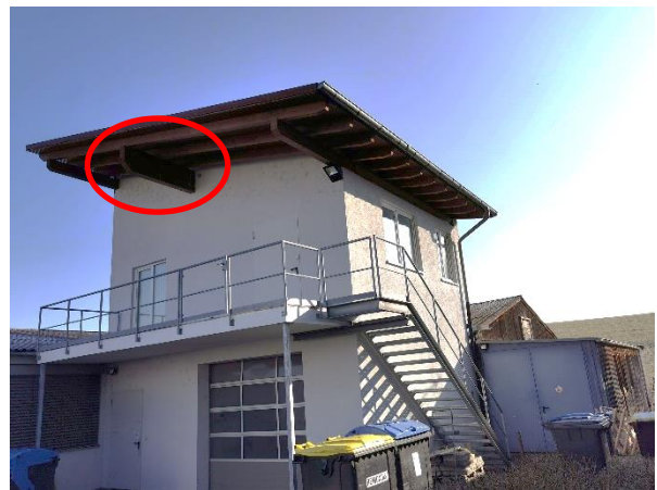
Abb. 14: Gebäude mit Holzbalken Sulzbacher Straße 168/1
