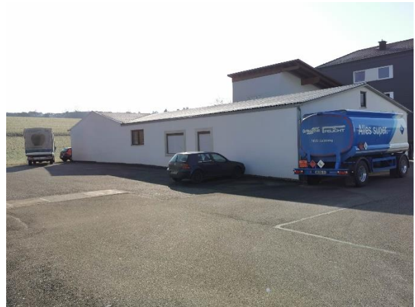
Abb. 12 Gebäude mit Wellblechdach Sulzbacher Straße 168/1
