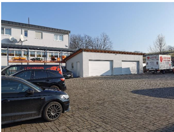
Abb. 9: Garage mit Holzverkleidung im Hinterhof der Sulzbacher Straße 178
