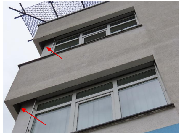
Abb. 14: Jalousiekästen an gesamten Gebäuden Sulzbacherstraße 140+141
