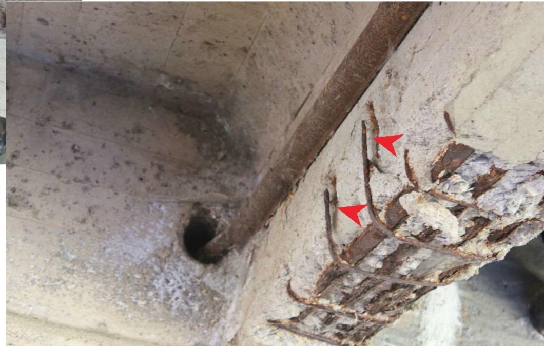
Querkraftbügel ist bereits losgelöst 27.09.2024
