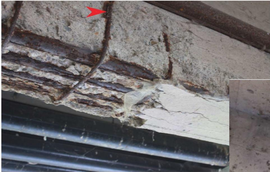
Querkraftbügel ist bereits losgelöst 27.09.2024
