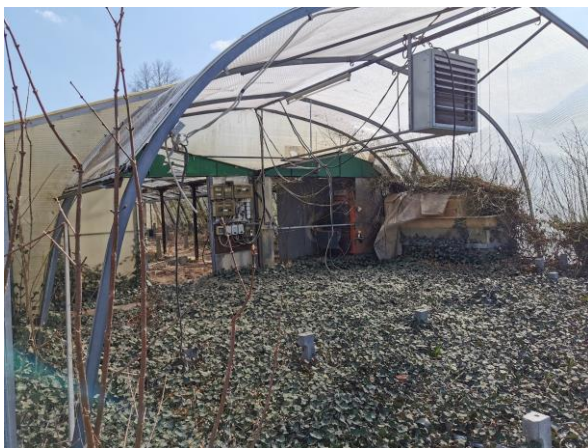
Abb. 4: Gewächshaus mit starkem Efeubewuchs
