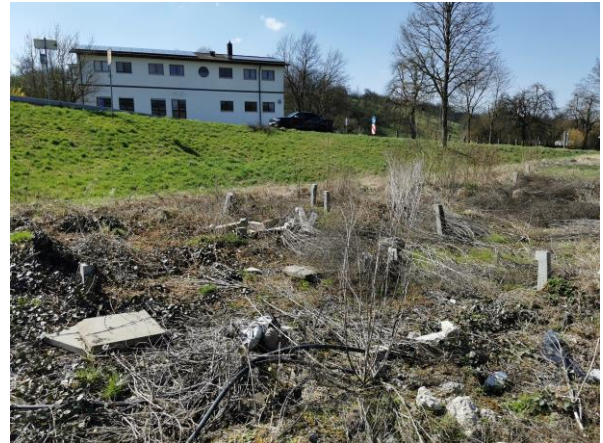
Abb. 3: ehemalige Gewächshausfläche mit Fundamenten und Schutt
