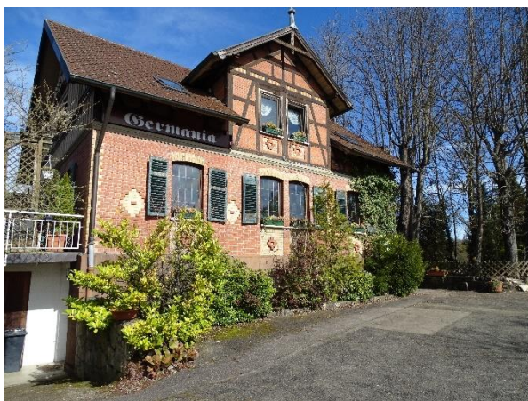
Abb. 3: Bestandsgebäude der ehemaligen Gaststätte Germania
