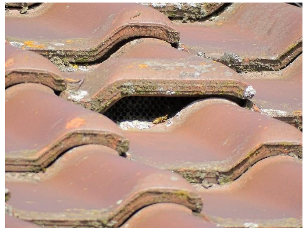
Abb. 20: Vergitterte Lüfterziegel auf dem Dach
