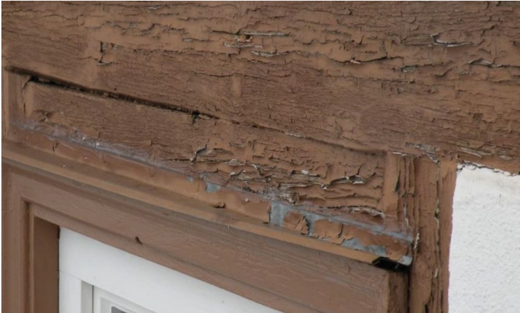
Feuchtegeschädigte Fachwerkhölzer
