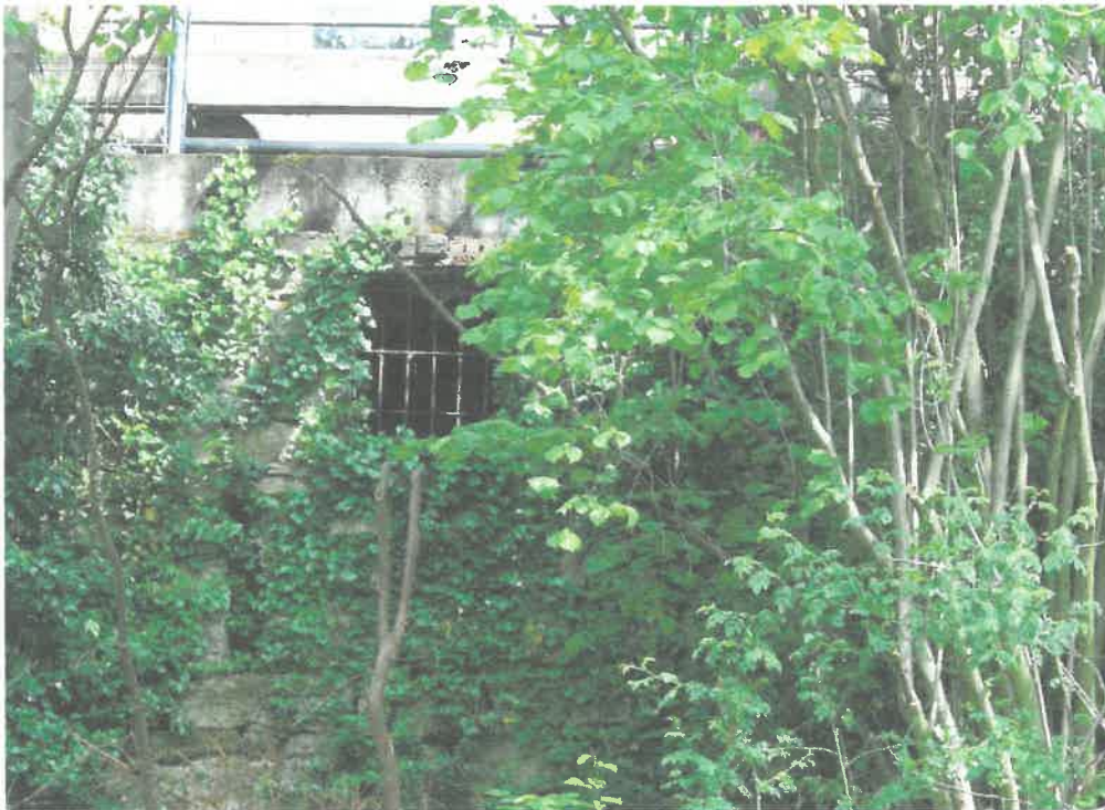
Abbildung 3: Mauer mit Fenster an Nordseite
