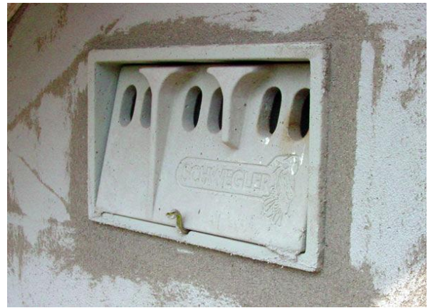
Abb. 29: Sperlingskoloniehaus 1SP, Montagebeispiel in Rohbau (Quelle: www.schwegler-natur.de )
