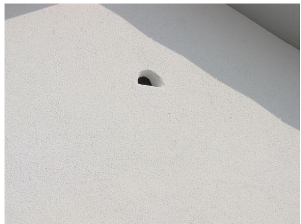
Abb. 27: Nist- und Einbaustein Typ 26, Einbaubeispiel Fassade (Quelle: www.schwegler-natur.de )
