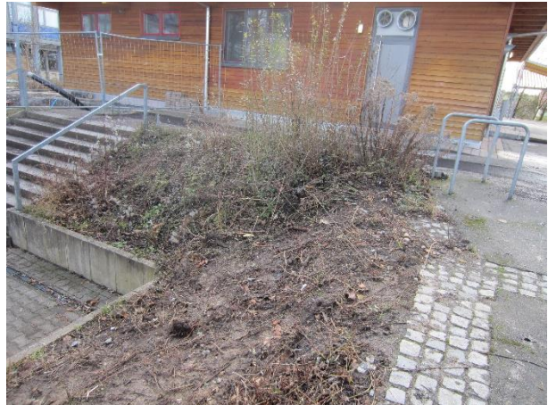
Abb. 9: Böschung am oberen Eingang zur Karl-Euerle-Halle
