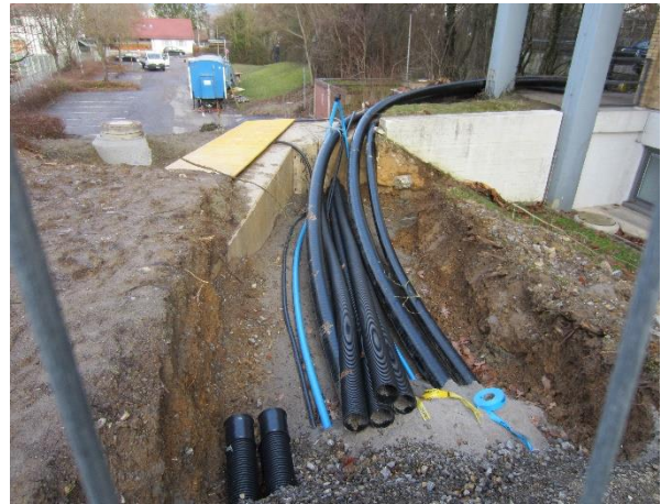
Abb. 3: Leitungsarbeiten am Max-Born-Gymnasium
