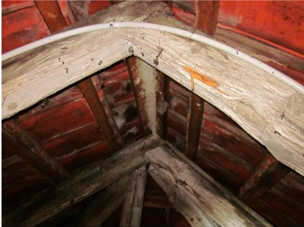
**Abb. 5:** Mit Mörtel verschlossene Öffnungen im Dachgiebel des Wohnhauses Holzwarth
