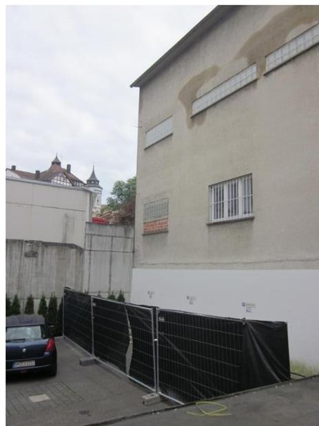
**Abb. 6:** s. Abb. 4: durch das Abdecken der Ziegel weicht die Bausubstanz durch
