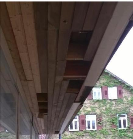
**Abb. 13:** Die unvollständige Holzverkleidung am Sowas-Kaufhaus wird durch Tauben genutzt
