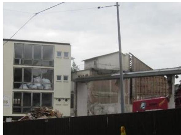
**Abb. 4:** Vorbereitung der 3. Etappe: Entkernungsarbeiten und abgedeckte Dachziegel beim Sowas-Kaufhaus
