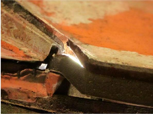
**Abb. 9:** Noch nicht verschlossene Spalten zwischen Ziegeln auf dem Dachboden des Wohnhauses Holzwarth
