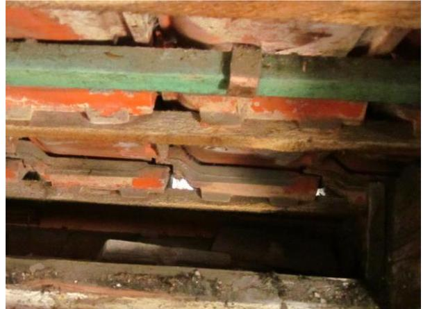
**Abb. 10:** Noch nicht verschlossene Spalten zwischen Ziegeln auf dem Dachboden des alten Sowas-Kaufhauses
