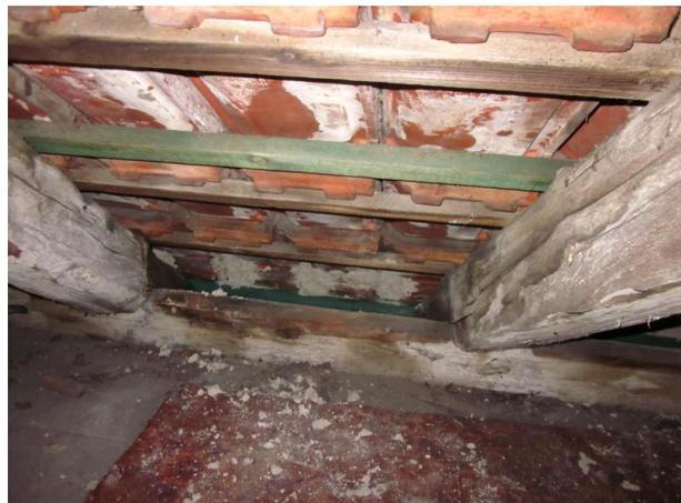
**Abb. 4:** Mit Mörtel verschlossene Öffnungen im Dachstuhl des Wohnhauses Holzwarth
